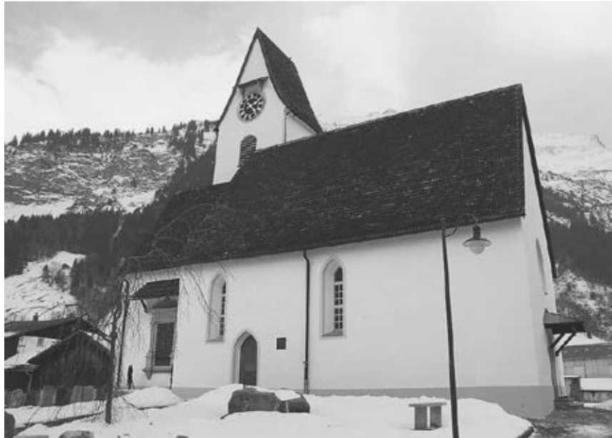
Tragische Naturkatastrophe: Die Elmer Kirche und die Bergsturzstelle (links vom Kirchturm).
