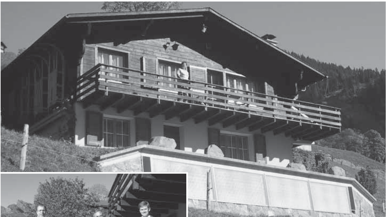
Ferienhaus der Fam. Keller mit den Solar-Panels.
