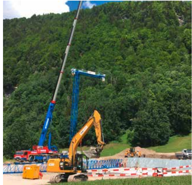
Der neue Kran wird mit einem Spezialfahrzeug aufgestellt.
