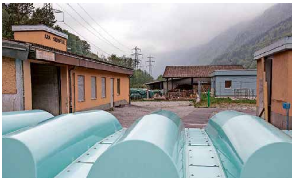
Wird anders: Im Sommer 2019 soll der Um- und Neubau der ARA Sernftal fertig sein. Der hintere Teil des Gebäudes wird abgerissen, dort entsteht neu das Schlachthaus. Im umgebauten Hauptgebäude wird die Fleischverarbeitung vorstatten gehen. Foto: Sasi Subramaniam
