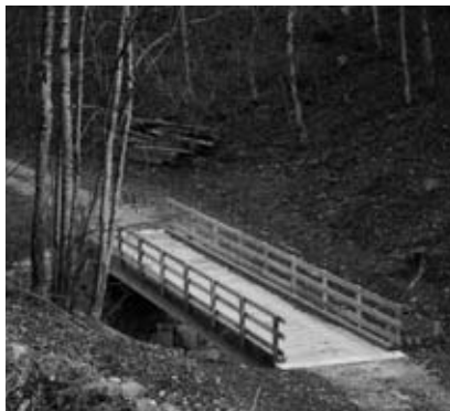
Brücke zur Wasserfassung
