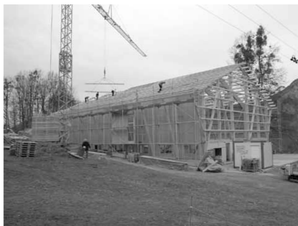
Stall in Obstalden. Marti AG Holzbau
