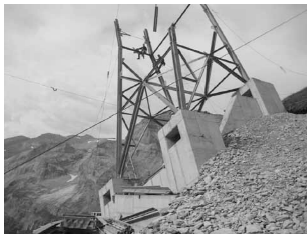
Masten der Bauseilbahn Kraftwerke Linth-Limmern in Linthal. Marti AG Bauunternehmung (ARGE)
