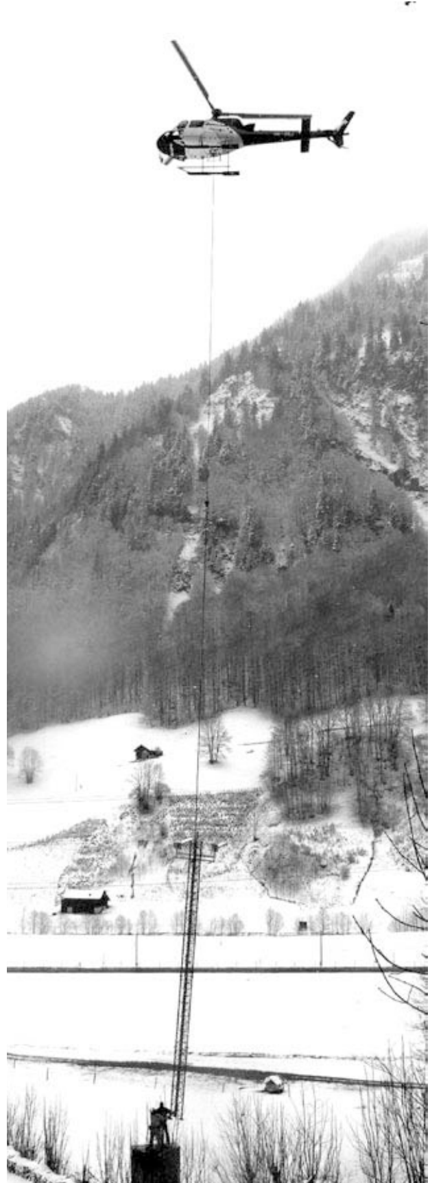
Die letzte Schraube ist gelöst und der Mast schwebt davon.
